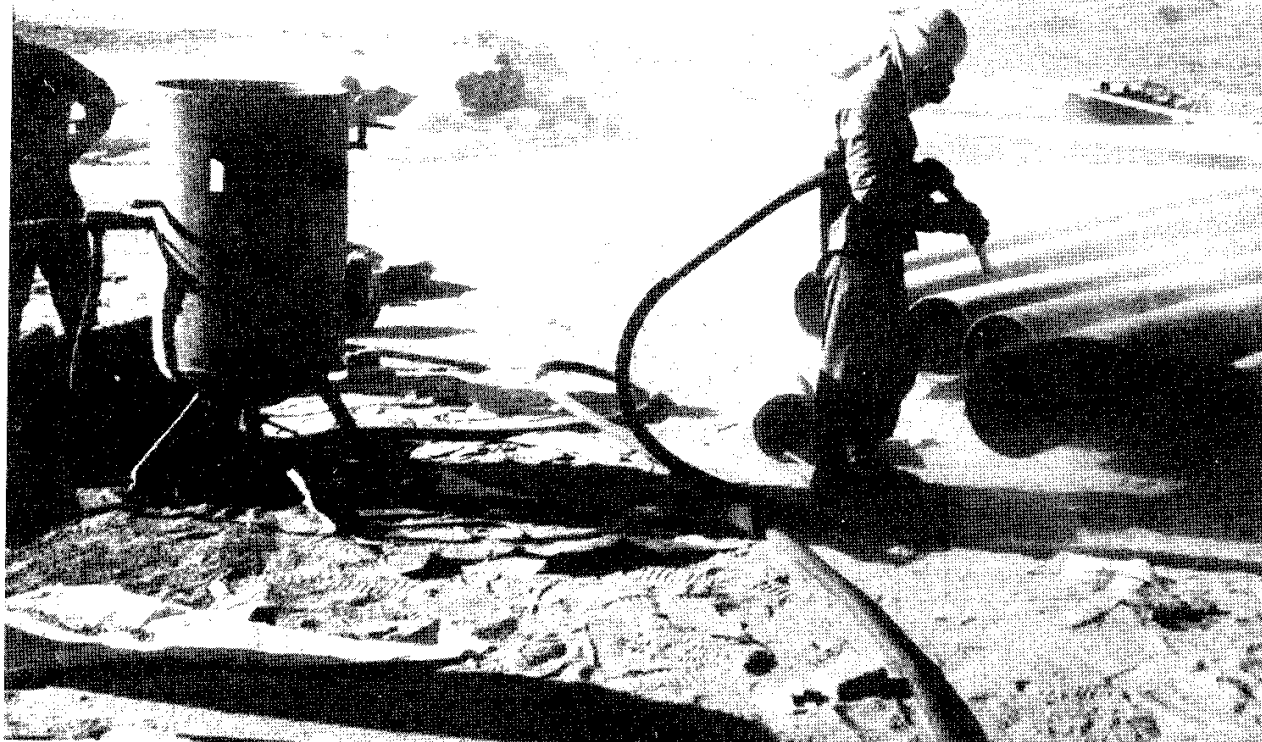
شکل ۹ - ۴۰ - عملیات ماسه پاشی.
